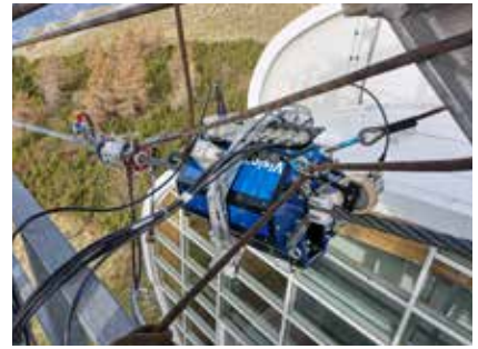
3D-kabelmeetuitrusting beoordeelt de kwaliteit van de kabel vanuit alle hoeken
